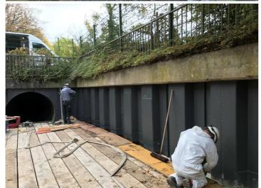
Im Auftrag des Lippeverbandes geht es um die Erneuerung des Profilbetons in dem Einlaufbauwerk zum Erhalt der Dauerhaftigkeit.
